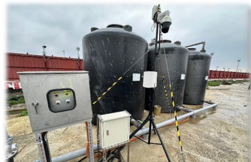
CCTV連動系統及灑水設備安裝
