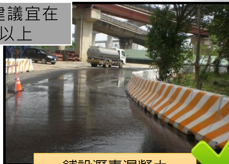
鋪設瀝青混凝土
