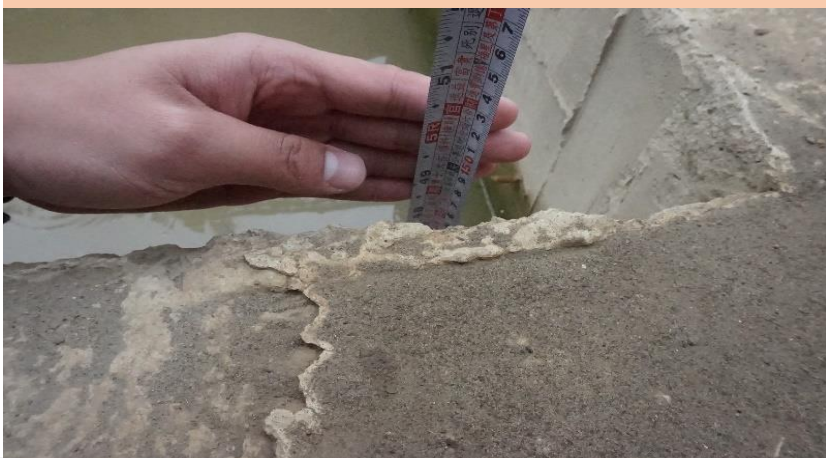
測量沉砂池深度大於1/2有效深度
