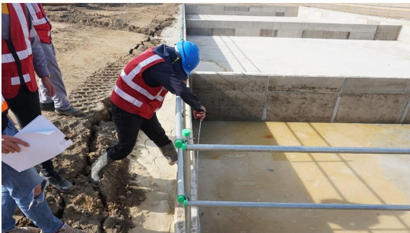
測量沉砂池深度大於1/2有效深度
