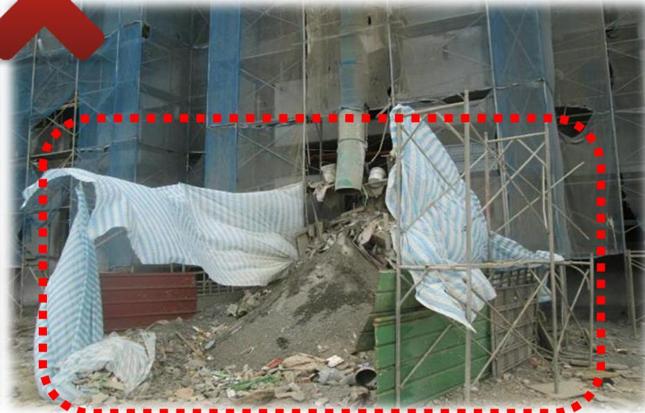
輸送管道出口，未設置可抑制粉塵逸散之圍籬並灑水設施，致產生揚塵。
