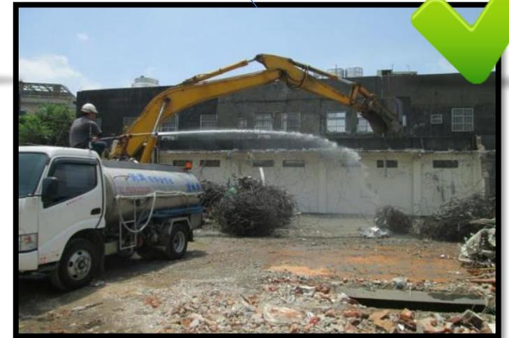
拆除作業進行時，配合加壓噴灑水
