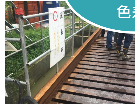
(2)廢水處理設備 (3)告示牌
