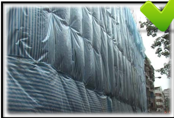
拆除結構體外包覆防塵布
