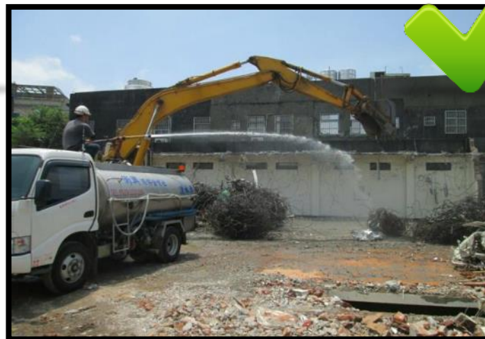
拆除作業進行時，配合加壓噴灑水
