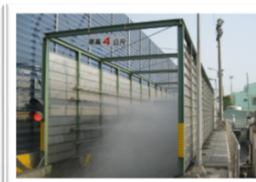
工區出入口 設置清洗車台設備
