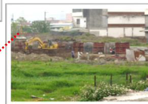
裸露地表 鋪稻草 植生 灑水
