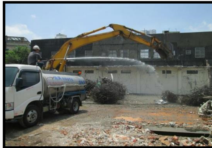
拆除作業進行時，配合加壓噴灑水
