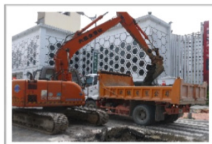
廢土不落地 挖掘路面保持乾淨
