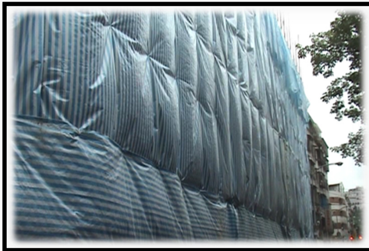
拆除結構體外包覆防塵布
