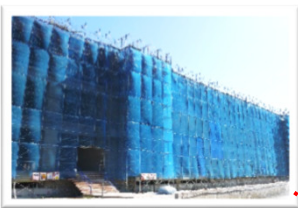
結構體與拆除 施工架外緣完全包覆
