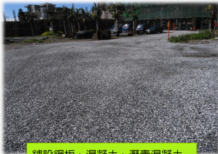
鋪設鋼板、混凝土、瀝青混凝土、粗級配或其他同等功能之粒料
