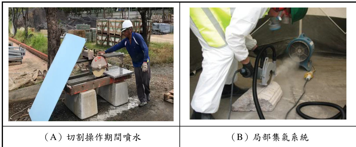
圖二十一 易致粉塵逸散之操作應採行之防制設施內容及標準
