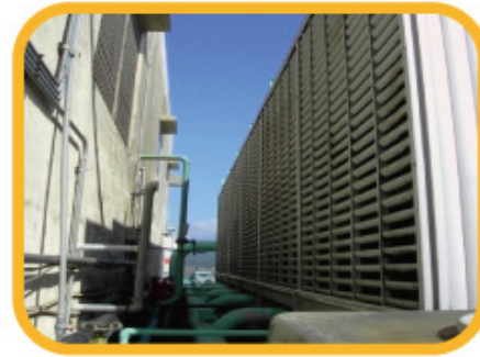
▲ 外氣入口與冷卻水塔距離過近
