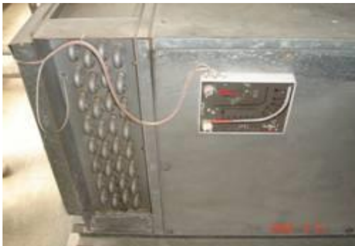
過濾網壓差感知裝置的檢修與維護
