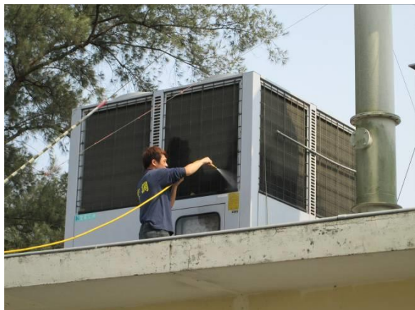
氣冷式冰水機及散熱鰭片維護與清潔
