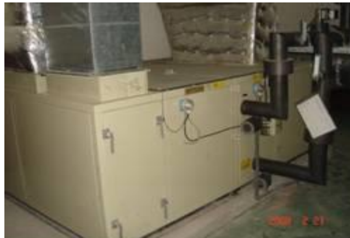
過濾網壓差感知裝置的檢修與維護
