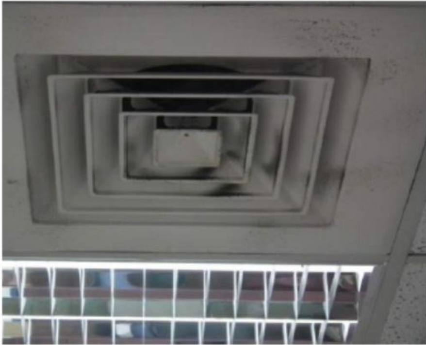
圖 16 中央空調箱或送風盤管系統空調出風口及空調回風口
