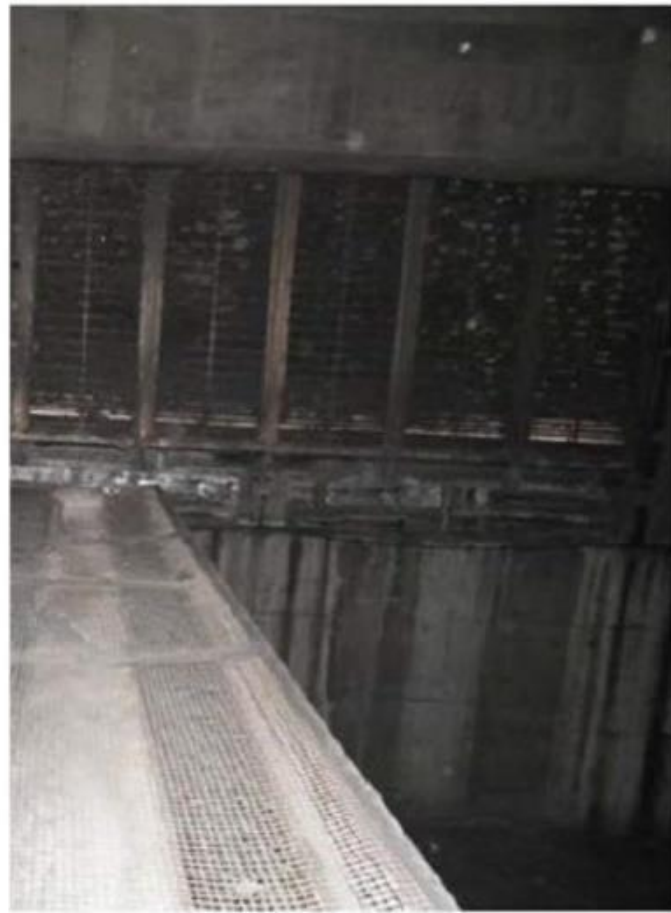
圖 29 外氣進氣口髒污與阻塞情形
