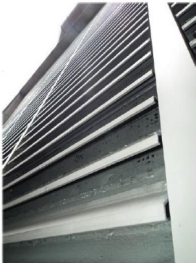
圖 29 外氣進氣口髒污與阻塞情形
