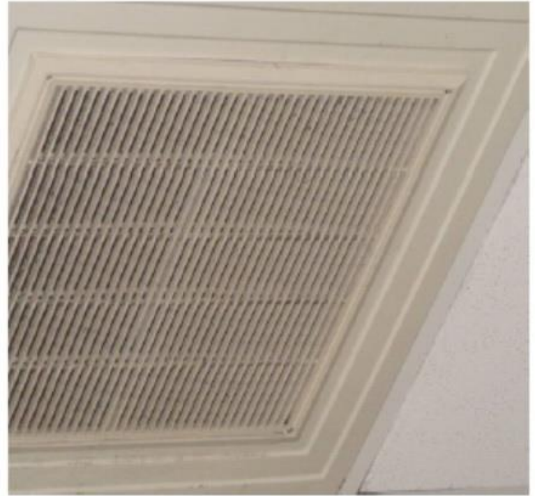
圖 16 中央空調箱或送風盤管系統空調出風口及空調回風口
