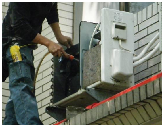
氣冷式冰水機及散熱鰭片維護與清潔
