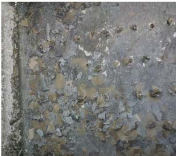
冷卻水塔分散水盤阻塞及冷卻水溢流
