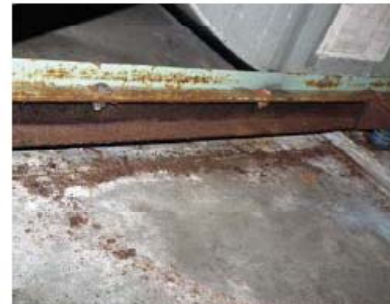
空調系統冷卻盤管髒污情形
