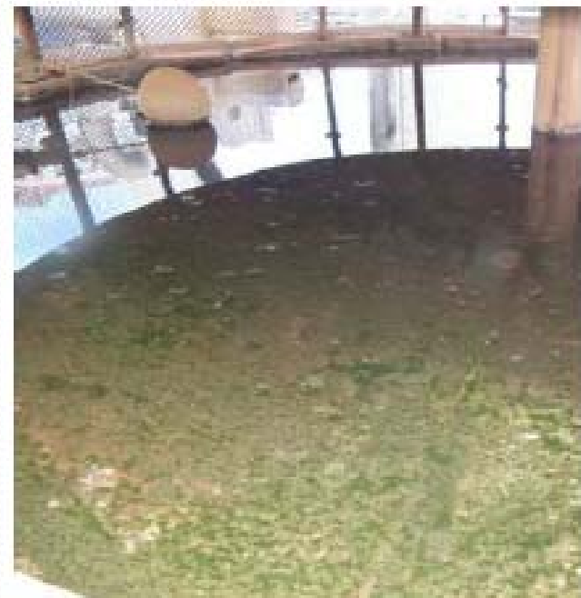
冷卻水塔之貯水池內藻類孳生情形
