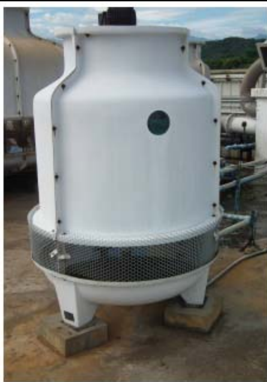
常見冷卻水塔結構體外觀
