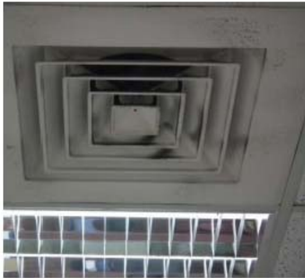
中央空調箱或送風盤管系統空調出風口及空調回風口
