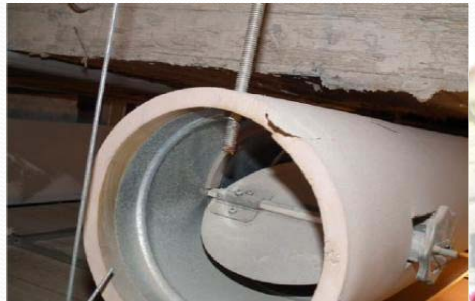
外氣輸送風管之出風口具有手動可調式風門
