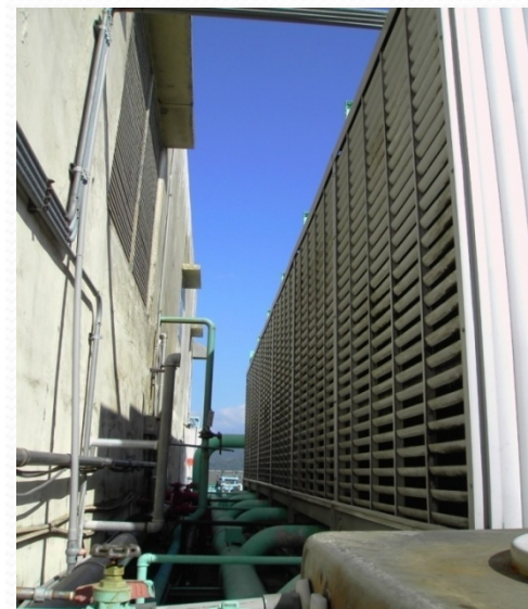
外氣入口與冷卻 水塔距離過近
