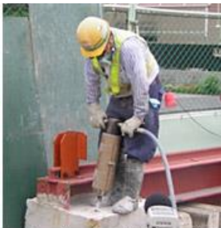
ブレーカーノイズサイレンサー 86.0dB
