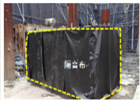
發電機設備外圍設置隔音布
