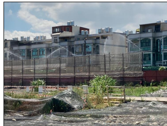
自動灑水設備
