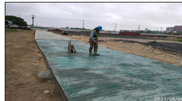
施工便道養護
