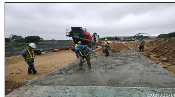
施工便道澆置
