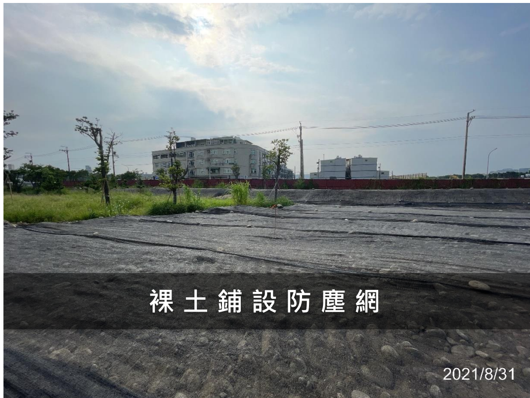
裸土區大量鋪設防塵網
