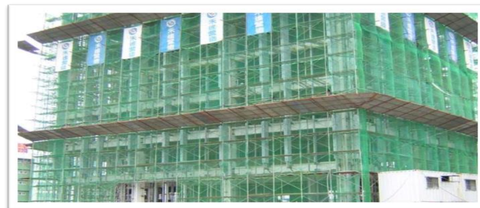
結構體設置防塵網
