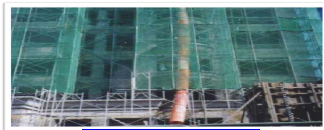
密閉輸送管道
