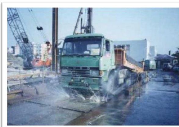
自動洗車設備
