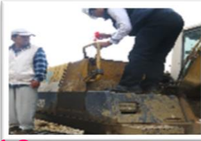
10 施工機具含硫 量 需使用合法油品
