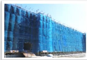
7 結構體 施工架外緣完全包覆
