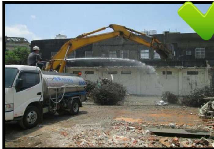
拆除作業進行時，配合加壓噴灑水
