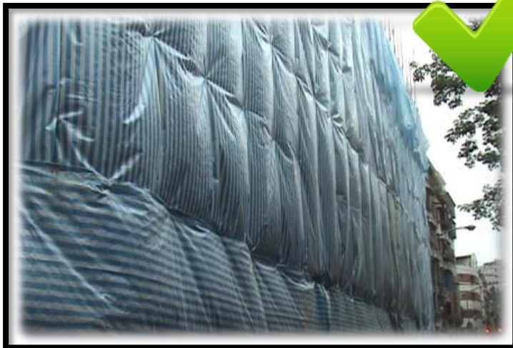
拆除結構體外包覆防塵布
