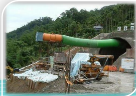
12 粒狀物排管道 排氣井裝集塵設備
