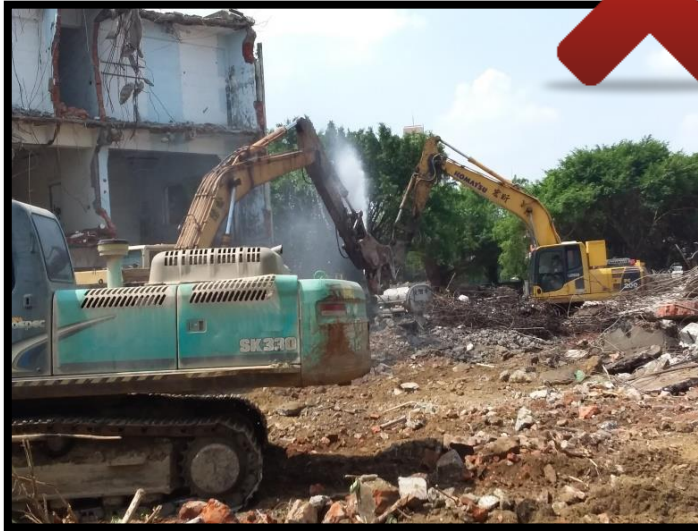
結構體未包覆防塵網(布) (缺失記點4點)
