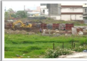
5 裸露地表 鋪稻草.植生.灑水
