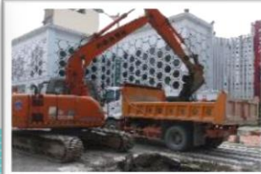
廢土不落地 挖掘路面保持乾淨
