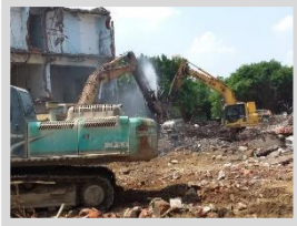
11 拆除作業 結構體拆除
