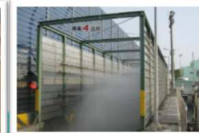
6 工地出入口 設置清洗車台設備
