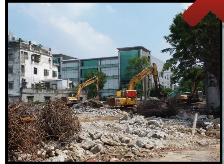
第一級營建工地未採行灑水及 結構體包覆塵網 (缺失記點10點)
