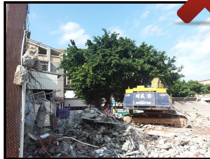
未設置加壓灑水裝置 (缺失記點4點)
