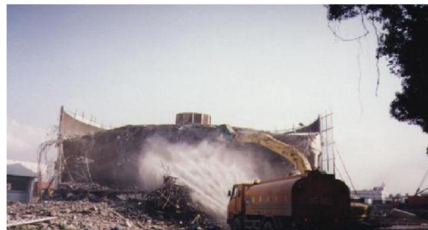
加壓灑水設備
