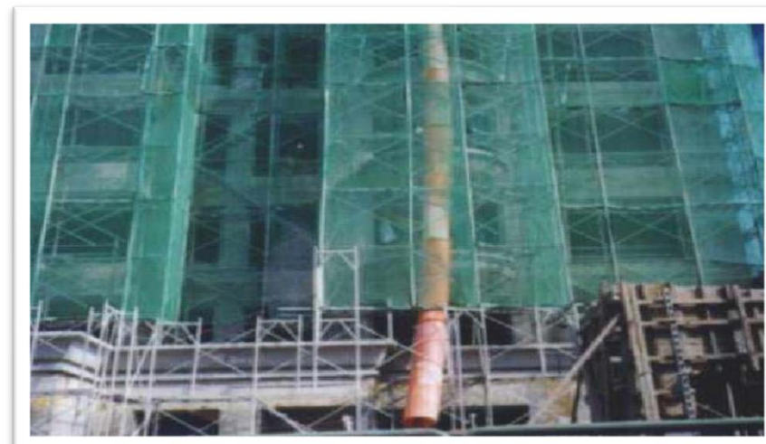
密閉輸送管道
