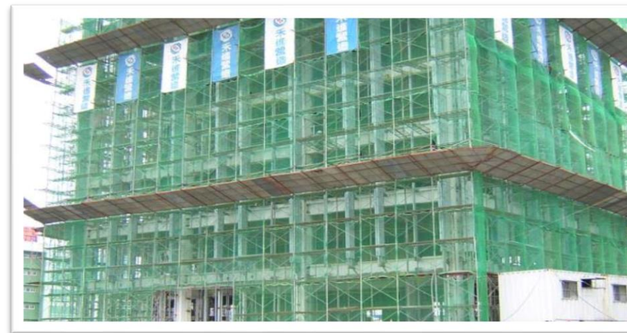
結構體設置防塵網
