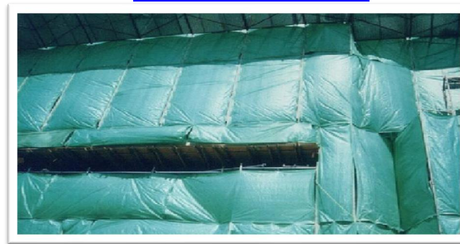
結構體設置防塵布
