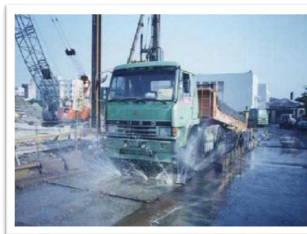
自動洗車設備
