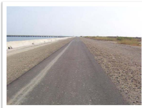
瀝青混凝土鋪設
