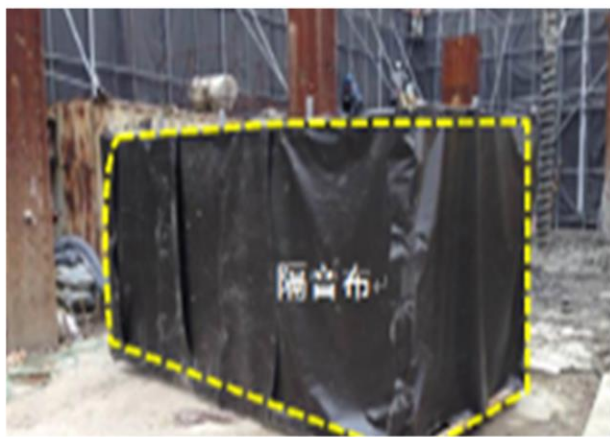
發電機設備外圍設置隔音布
