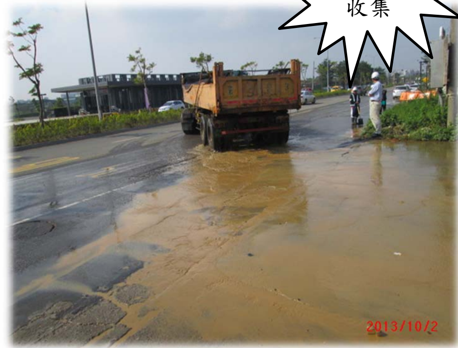
車輛進出出入口，其污水任意放流未收集，影響路面清潔
