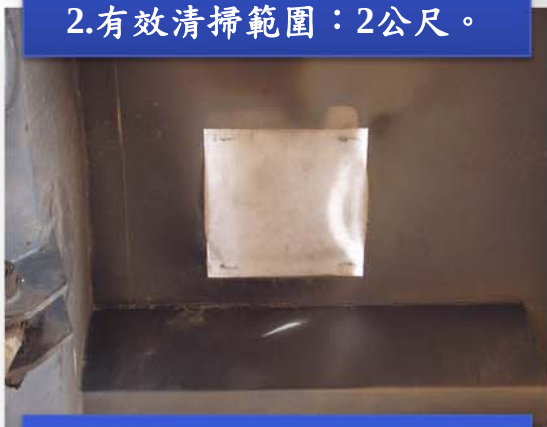
D. 排氣口：應加裝濾布，濾除排氣中之粒狀污染物
