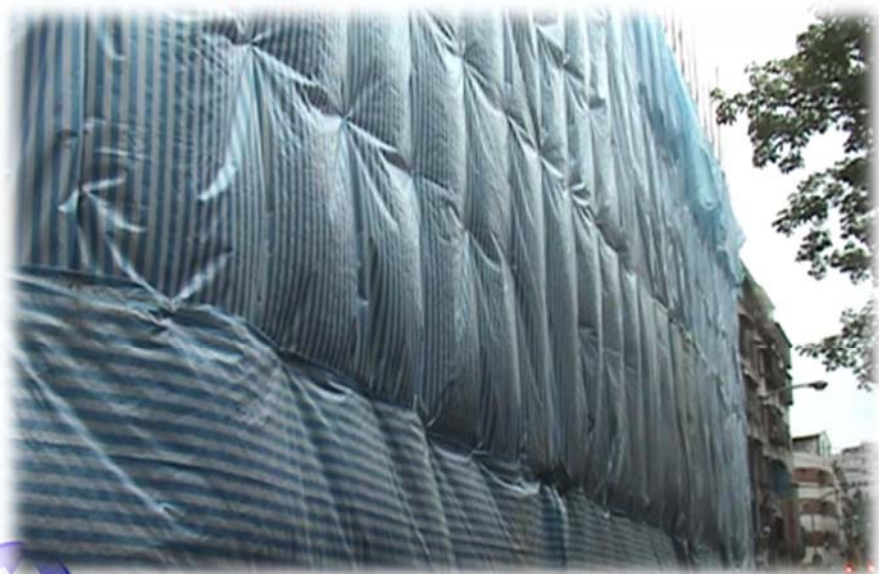
拆除結構體外包覆防塵布
