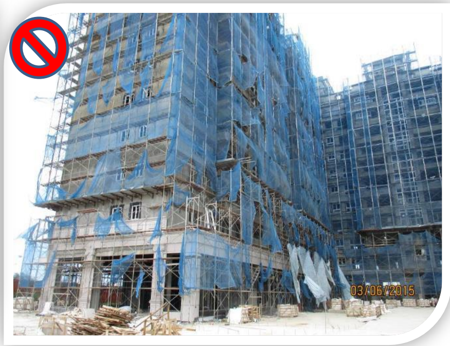
防塵布、防塵網破損
