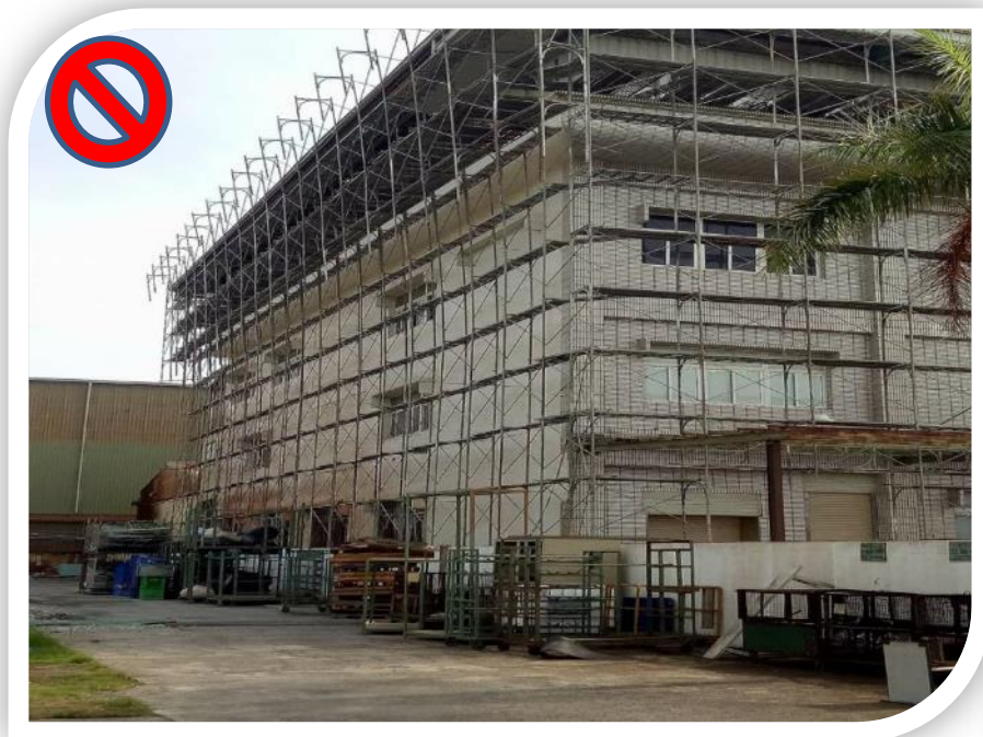
結構體無設置防制設施
