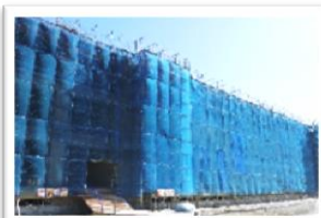
▶ 結構體與拆除 施工架外緣完全包覆
