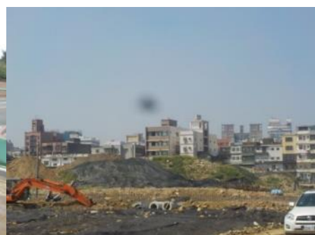
區域開發工程
