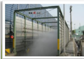
▶ 工地出入口 設置清洗車台設備
