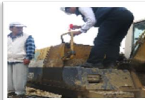
▶ 施工機具含硫量 需使用合法油品
