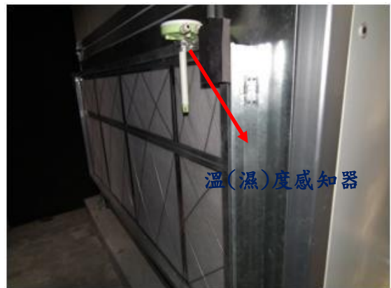
圖 36 空調控制與感知裝置的檢修與維護
