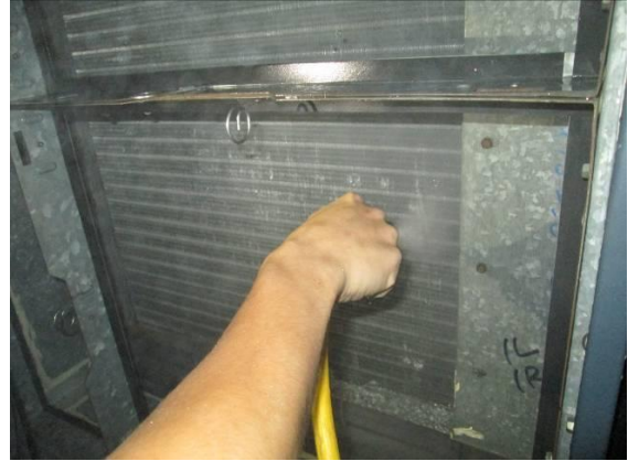
圖 35 空調室內側熱交換器清潔與維護
