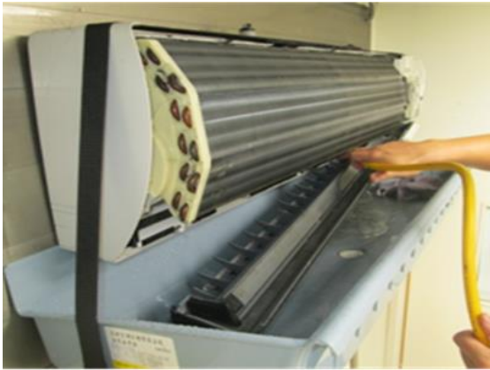
圖 35 空調室內側熱交換器清潔與維護
