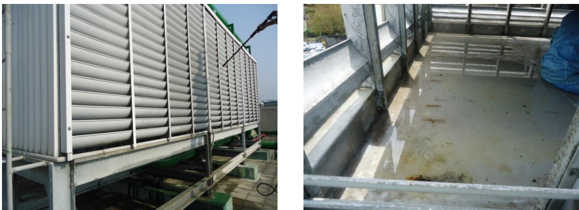
圖 30 冷卻水塔維護與清潔
