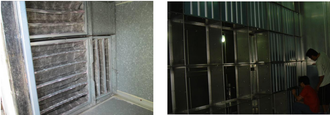
圖 39 空調過濾網檢修與維護
