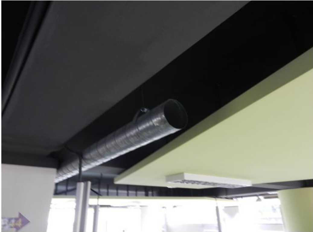
圖 10 外氣輸送風管之出風口不具有風門
