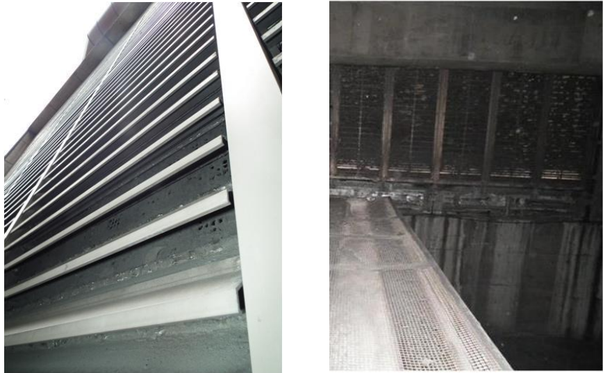
圖 29 外氣進氣口髒污與阻塞情形
