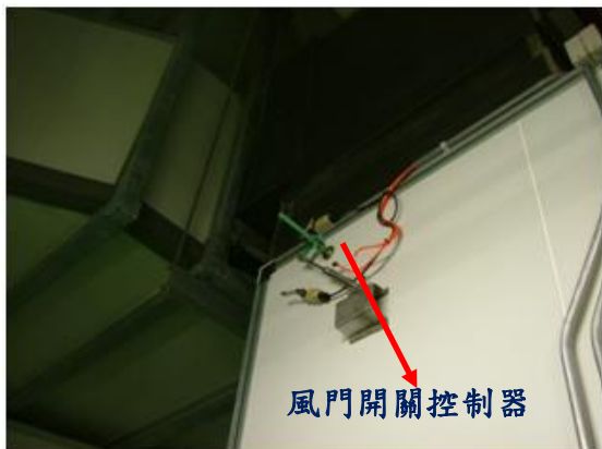
圖 36 空調控制與感知裝置的檢修與維護
