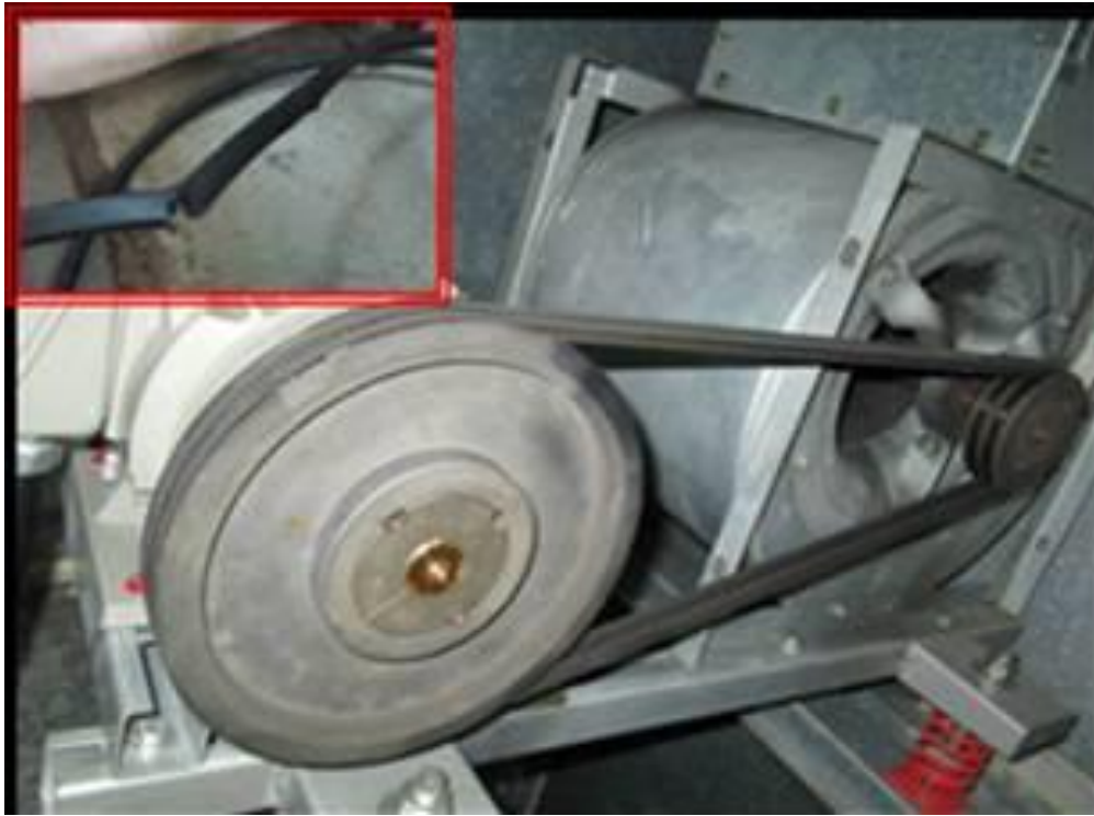
圖 34 空調箱皮帶檢查與更換
