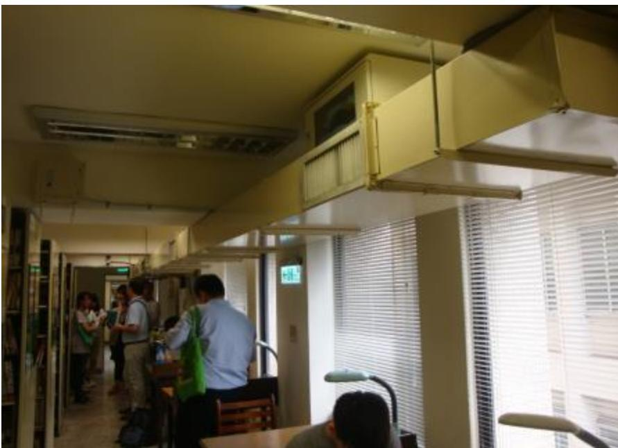
圖3.2 引入外氣直接進入落地型空調箱之改善案例
