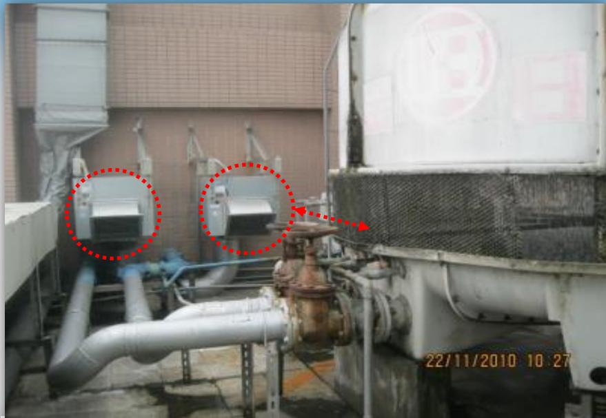
(a)外氣引入口靠近冷卻水塔
