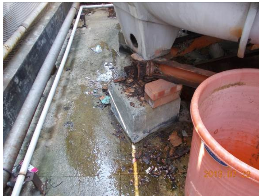
冷卻水塔漏水
