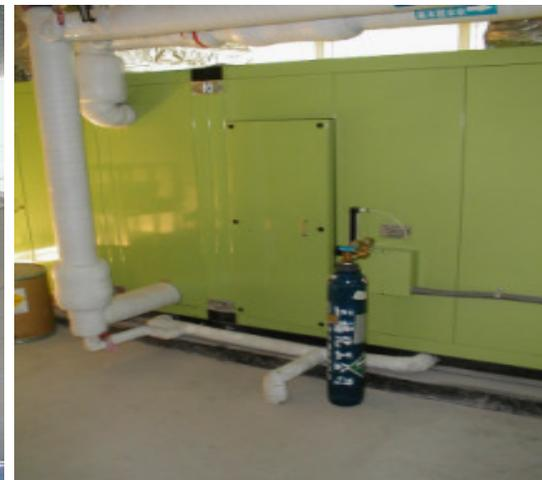
圖2-5 中央空調系統空調機 (Air Handling Unit System, AHU)
