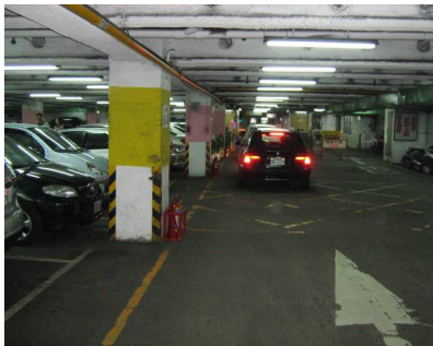
地下停車場車輛進出頻繁 換氣率應提高
