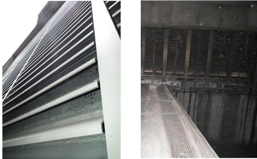
圖 29 外氣進氣口髒污與阻塞情形
