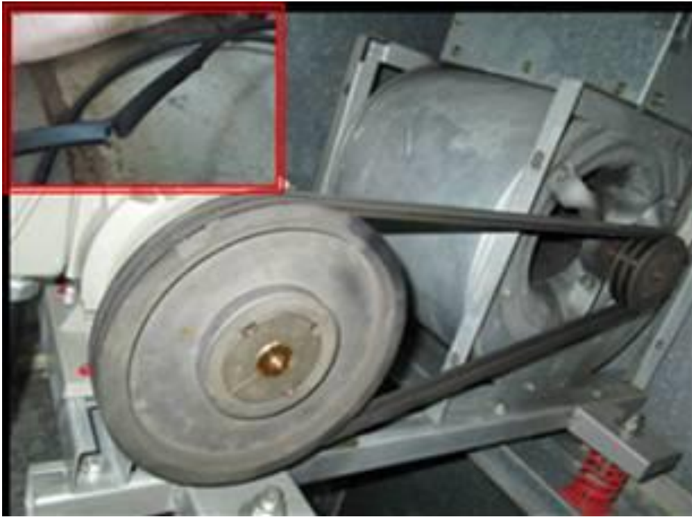
圖 34 空調箱皮帶檢查與更換
