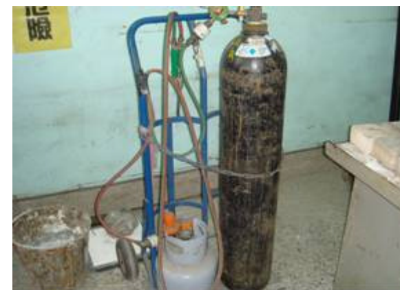
高壓氣體設備-鋼瓶
