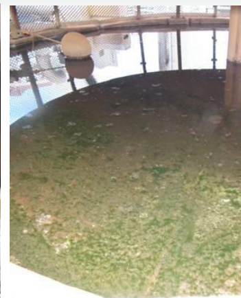
冷卻水塔之貯水池內藻類孳生情形
