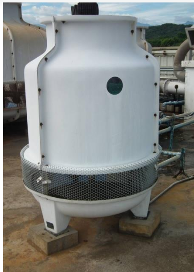
常見冷卻水塔結構體外觀
