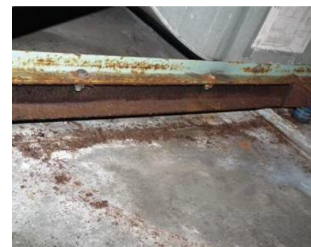
調系統冷卻盤管髒污情形
