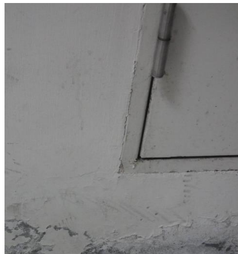
室內建材孳生黴菌及牆面壁癌
