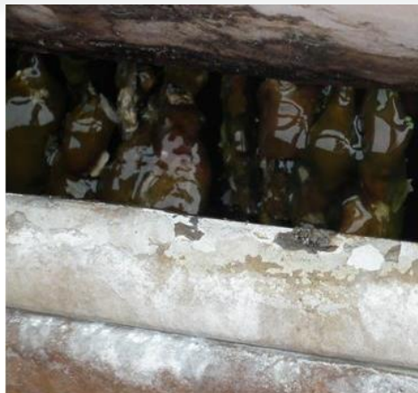
冷卻水塔之貯水池內藻類孳生情形
