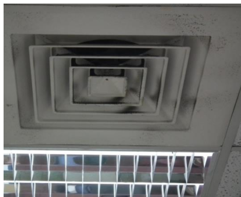
中央空調箱或送風盤管系統空調 出風口及空調回風口
