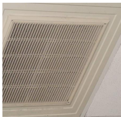
中央空調箱或送風盤管系統空調 出風口及空調回風口
