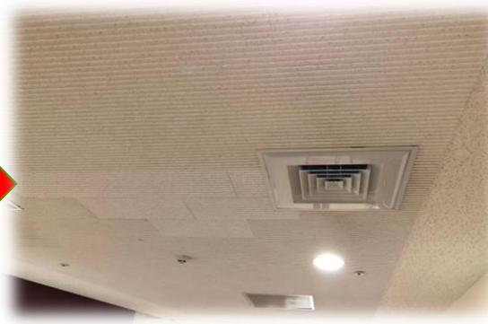
天花板更換後
