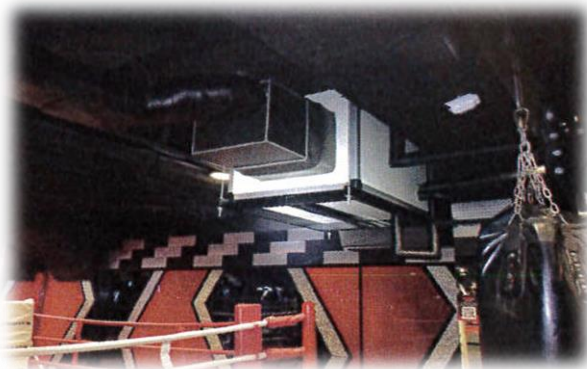
裝設預冷空調箱
