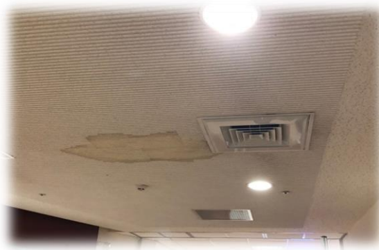
天花板更換前
