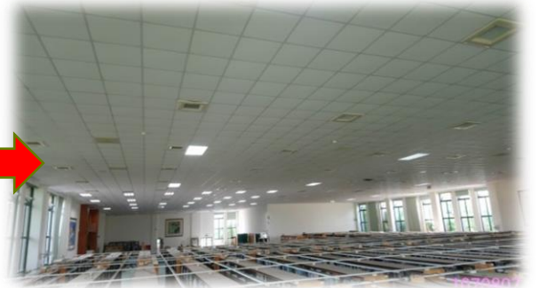
天花板更換後
