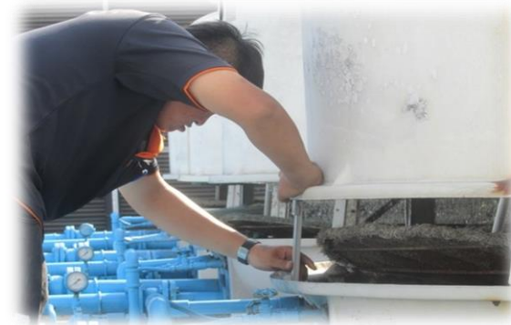
冷卻水塔防護網更換
