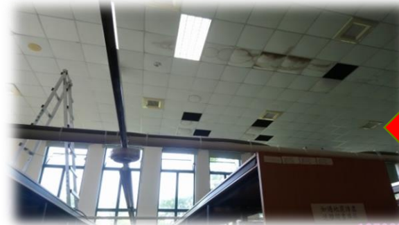
天花板更換前
