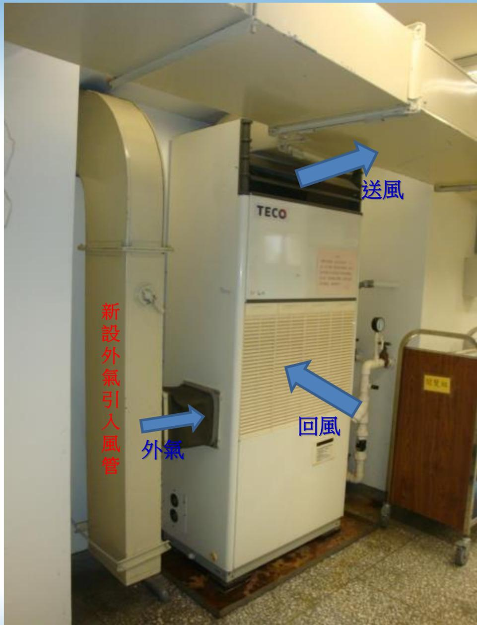
圖3-7 引入外氣直接進入落地型空調箱之改善案例
