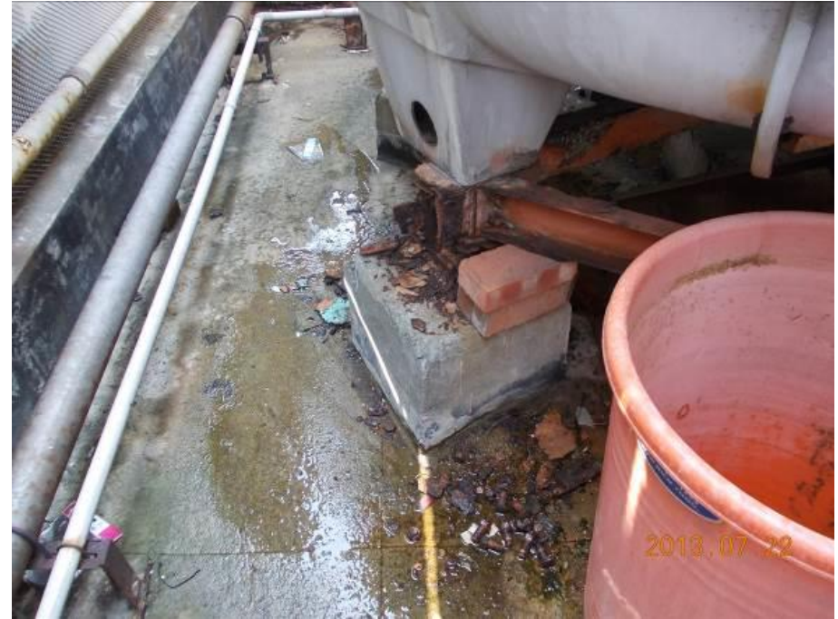
冷卻水塔漏水
