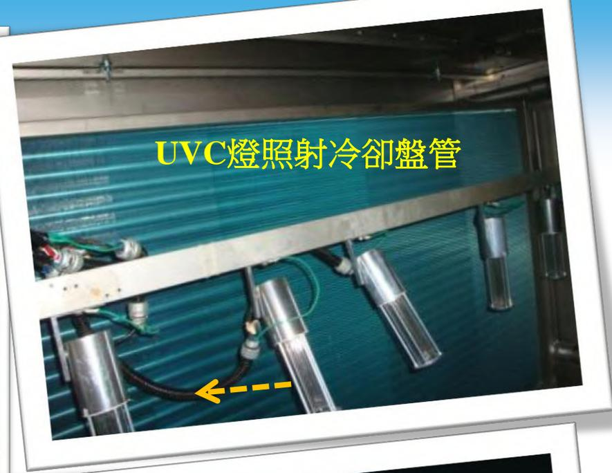
UVC燈照射冷卻盤管
