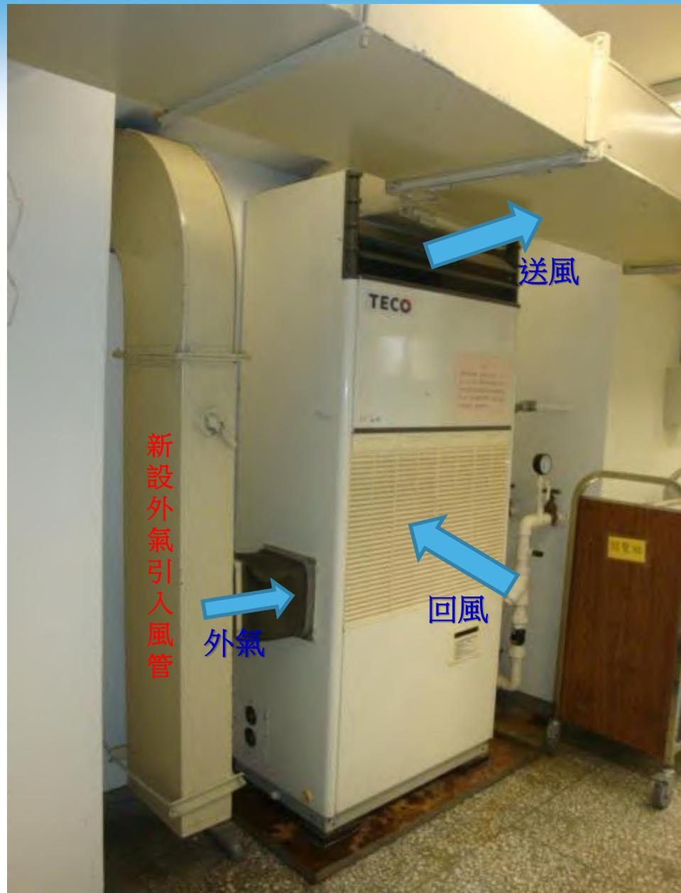
圖9.4 引入外氣直接進入落地型空調箱之改善案例
