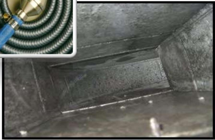
圖7.14 中央空調系統風管內部風刀清潔技術
