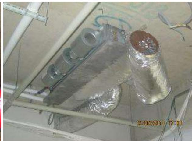
圖7.6 FCU空調系統風管機位於天板之構造樣式
