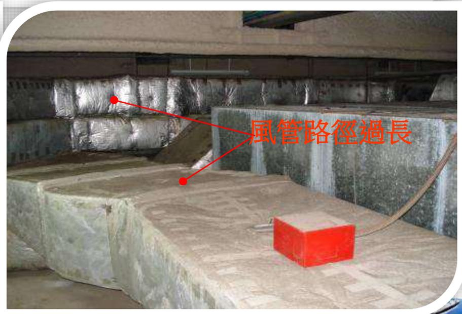
圖7.9 空調風管配置不當(90度急轉彎與扁平風管)
