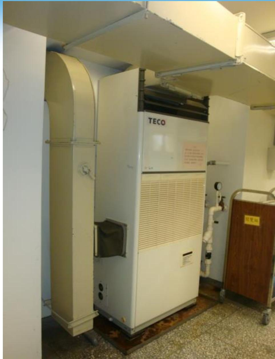
圖3.2 引入外氣直接進入落地型空調箱之改善案例
