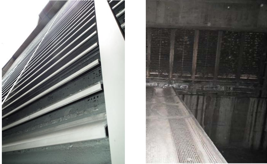
圖 29 外氣進氣口髒污與阻塞情形
