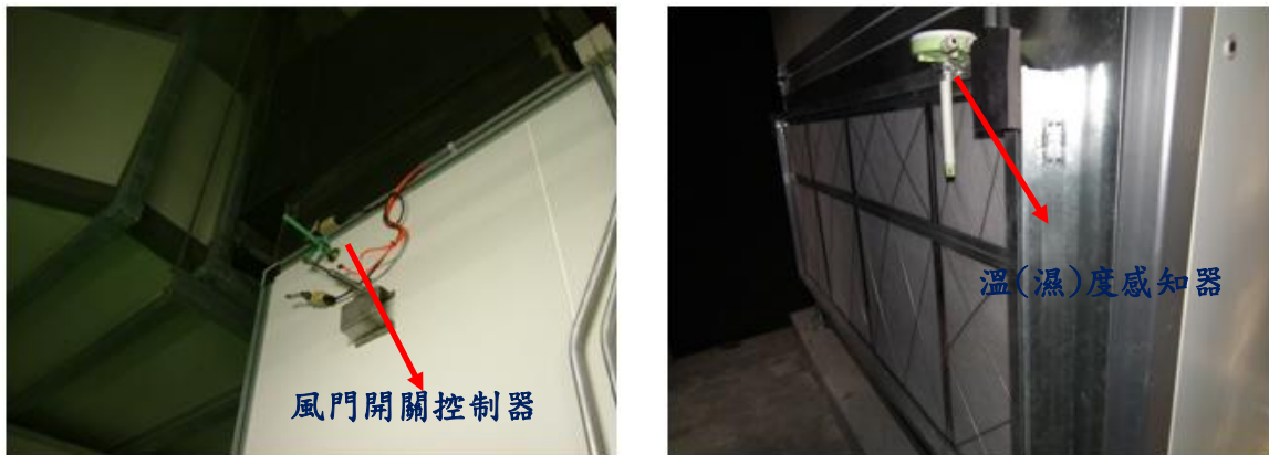
圖 36 空調控制與感知裝置的檢修與維護
