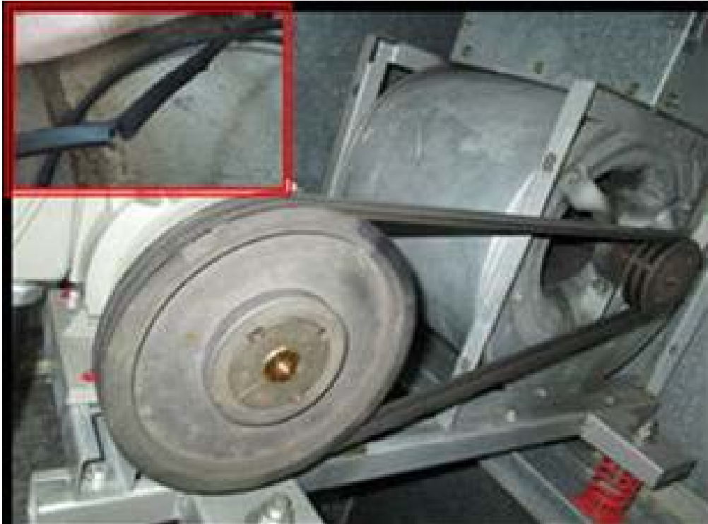
圖 34 空調箱皮帶檢查與更換
