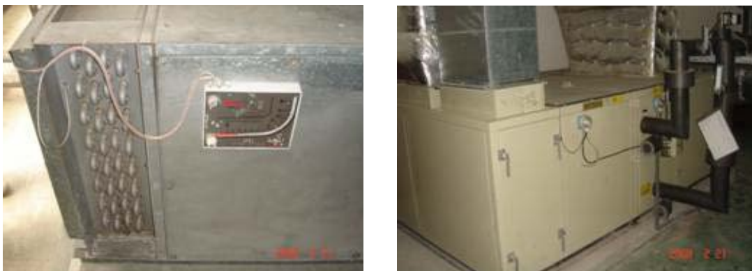
圖 38 過濾網壓差感知裝置的檢修與維護
