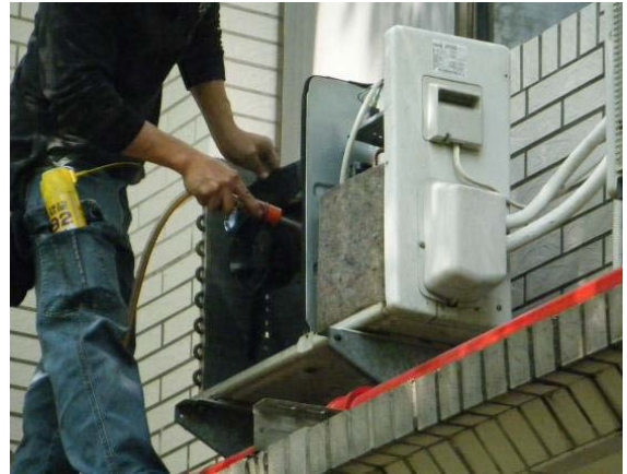
圖 31 氣冷式冰水機及散熱鰭片維護與清潔
