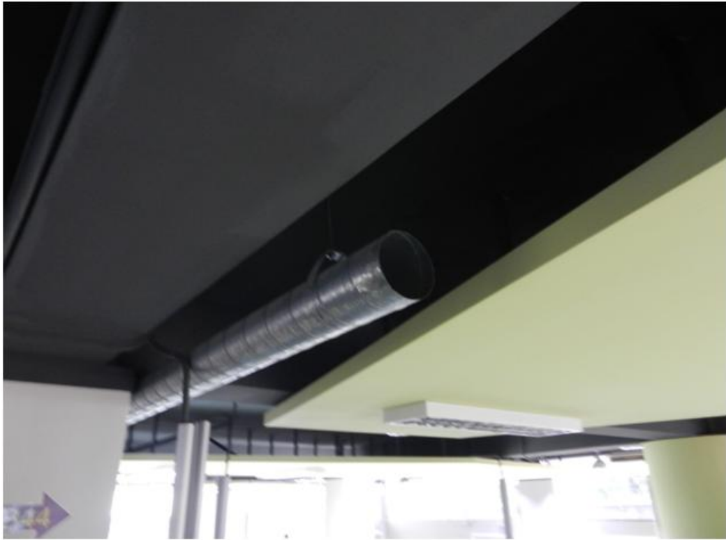
圖 10 外氣輸送風管之出風口不具有風門
