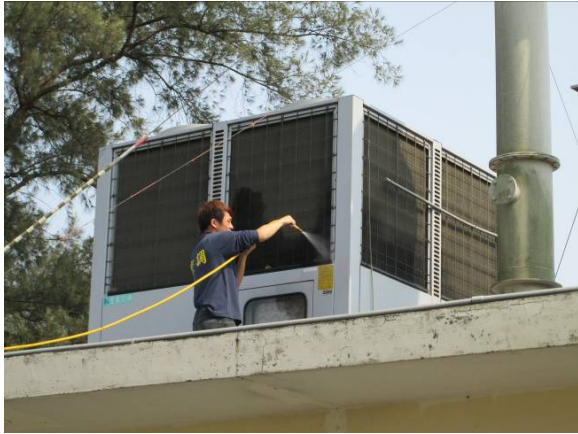
圖 31 氣冷式冰水機及散熱鰭片維護與清潔
