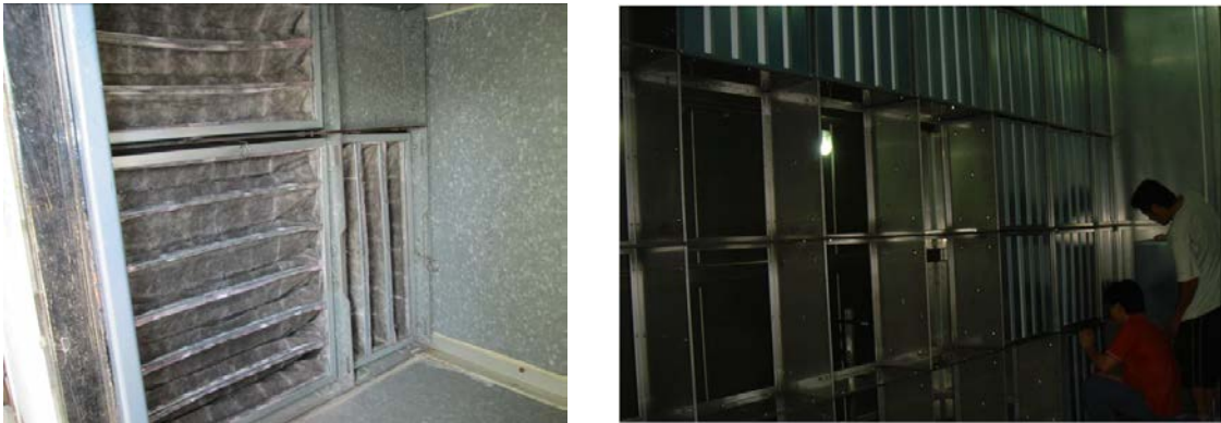
圖 39 空調過濾網檢修與維護
