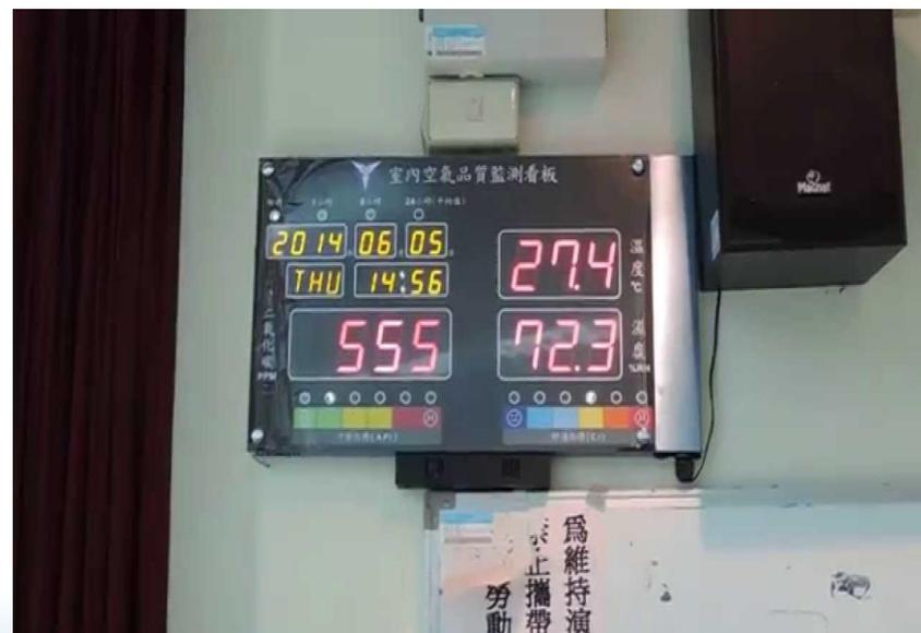
圖3-1 室內空氣品質二氧化碳連續監測設施顯示螢幕案例
