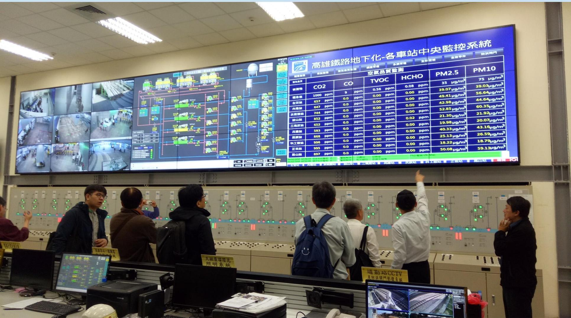
圖4-3 室內空氣品質連續監測設施中央自動控制系統
