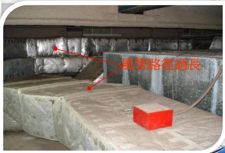
圖5.9 空調風管配置不當(90度急轉彎與扁平風管)
