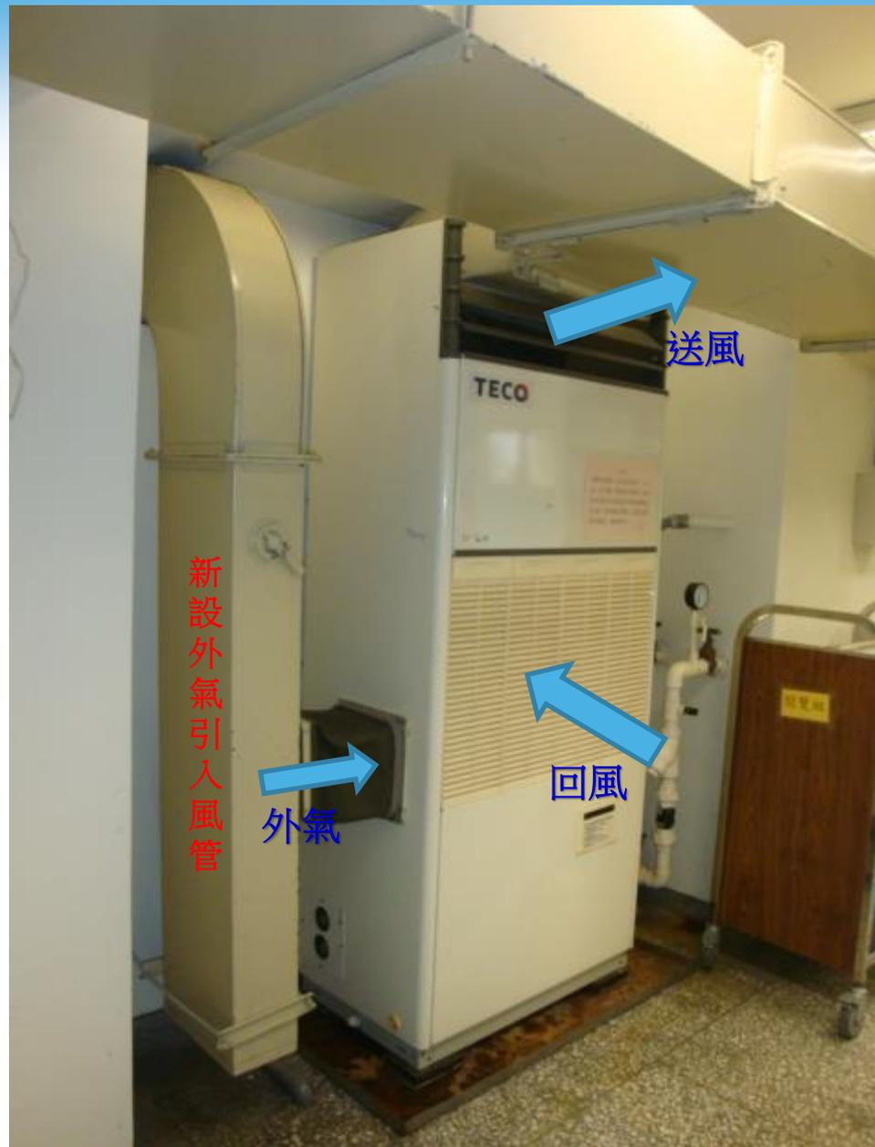
圖7.8 引入外氣直接進入落地型空調箱之改善案例
