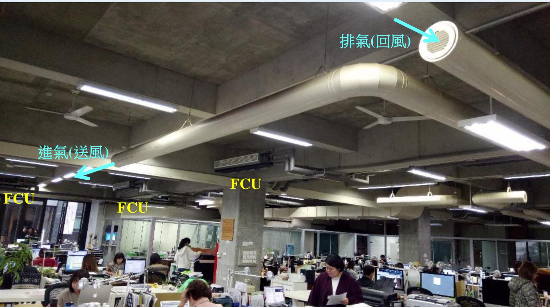
圖7.12 某辦公室以風機盤管(FCU)結合全熱交換器(HRV)引入外氣之案例
