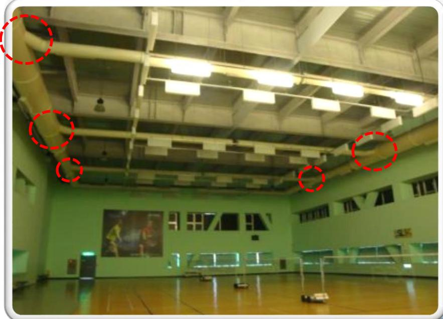
圖5.10 較佳(圓滑)的管線配置型態
