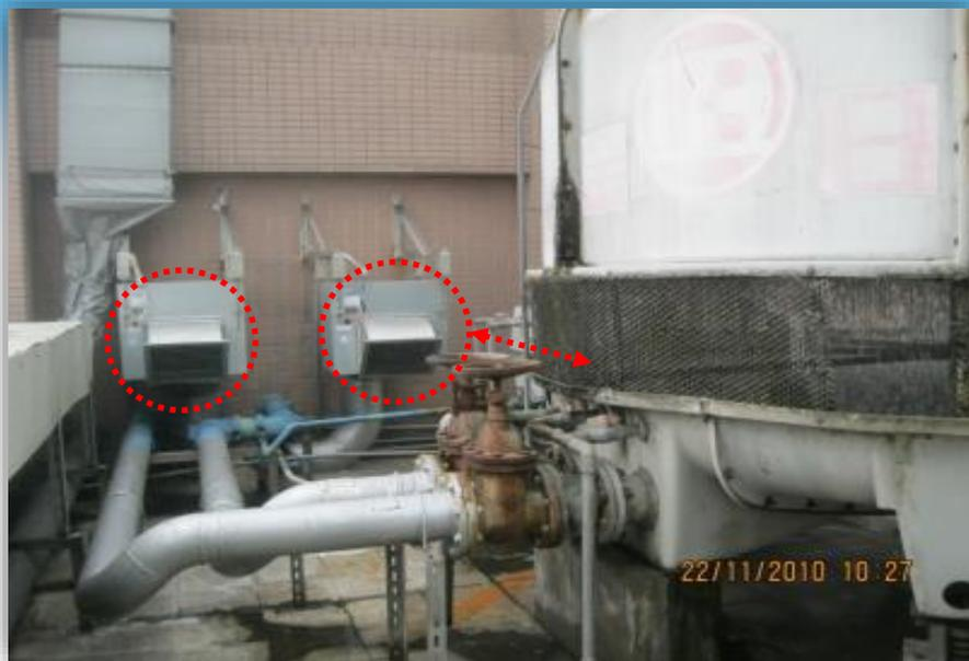
(a)外氣引入口靠近冷卻水塔
