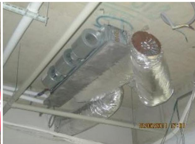
圖5.6 FCU空調系統風管機位於天板之構造樣式
