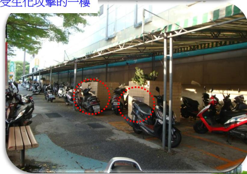
圖2.16 一樓外氣引入口遭受污染之情形
