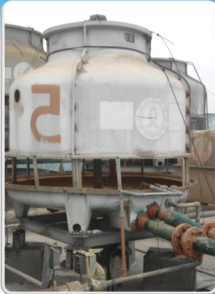
圖2.30 冷卻水塔防護網脫落未即時修護
