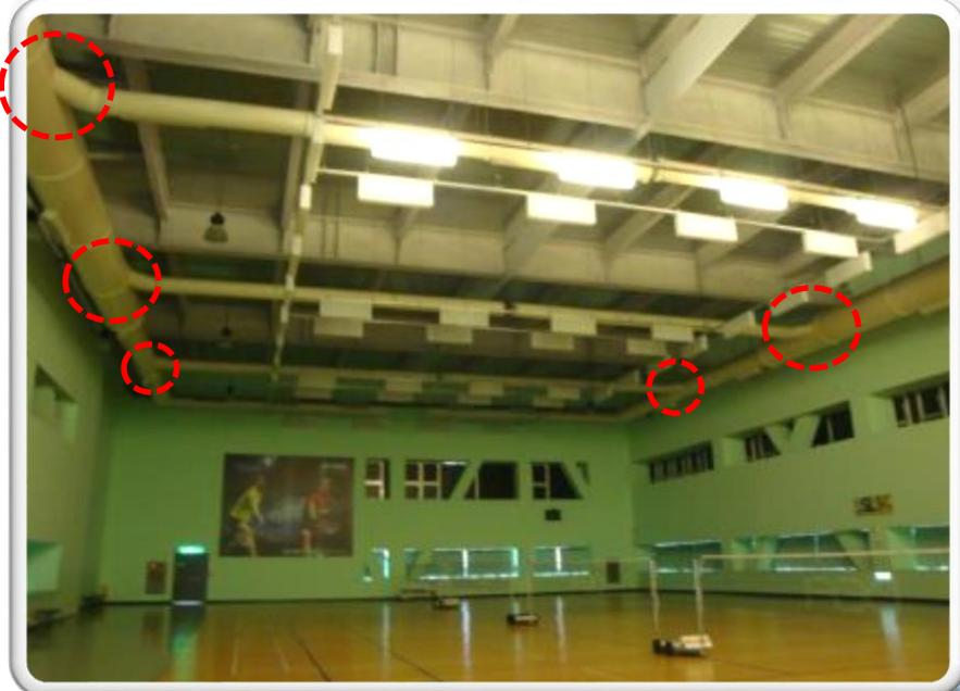
圖2.24 較佳(圓滑)的管線配置型態
