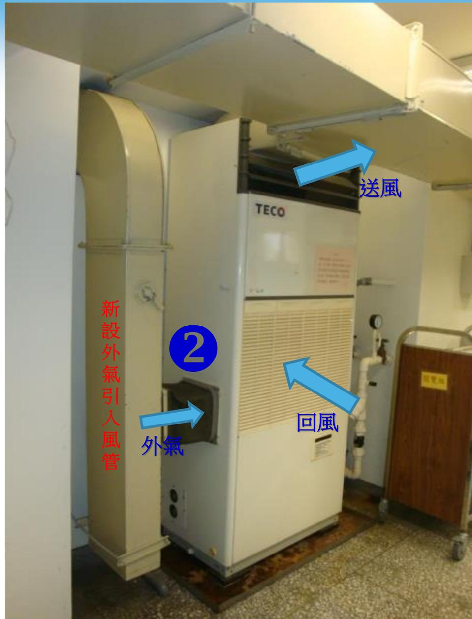
圖5.4 引入外氣直接進入落地型空調箱之改善案例
