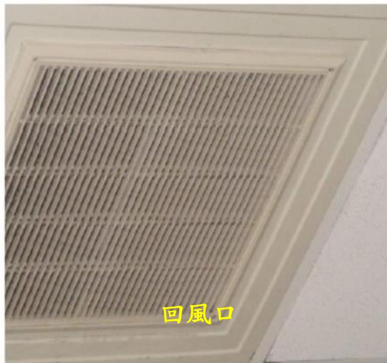
圖2.22 中央空調箱或送風盤管系統空調出風口及空調回風口積塵情形
