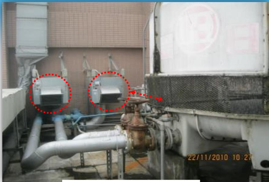
外氣引入口靠近冷卻水塔
