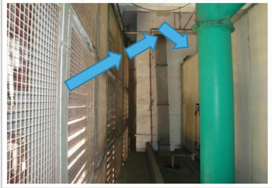
圖2.6 間接外氣引入方式往往無法確保外氣能真正進入空調箱
