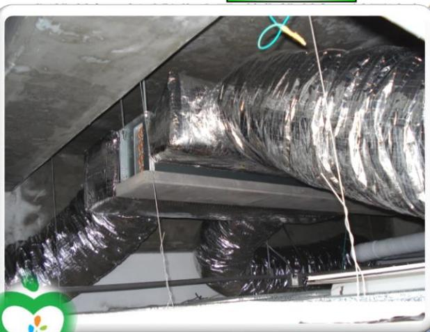
圖2.9 FCU空調系統室內循環機制示意圖
