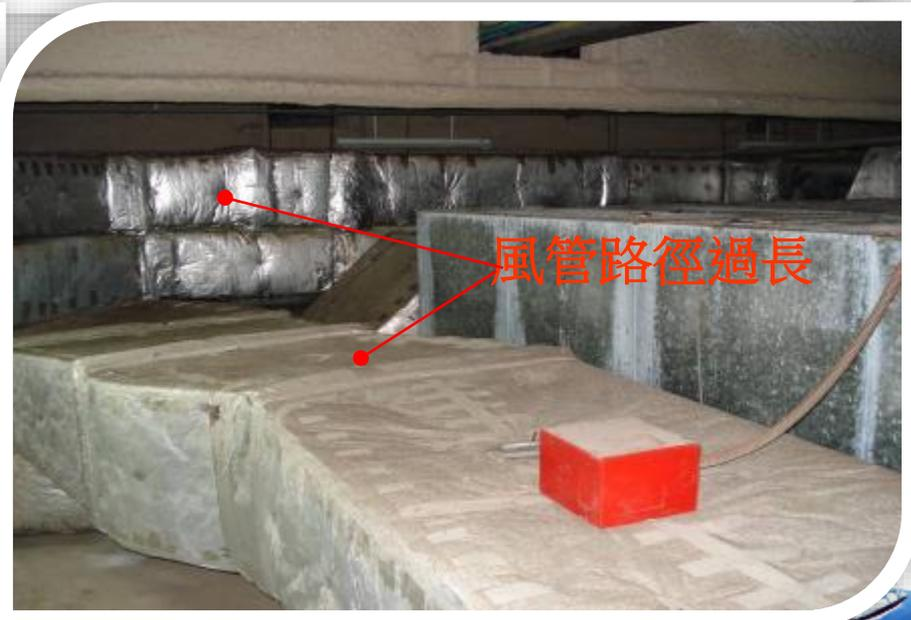
圖2.23 空調風管配置不當(90度急轉彎與扁平風管)
