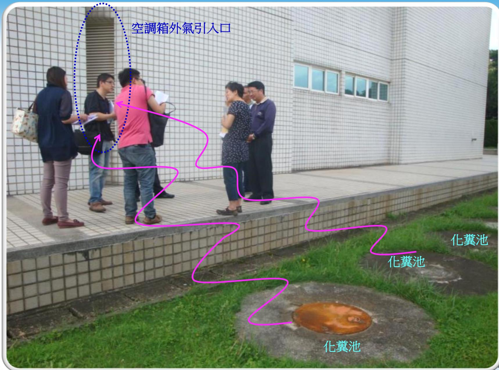
圖2.18 外氣引入口具室外污染源案例
