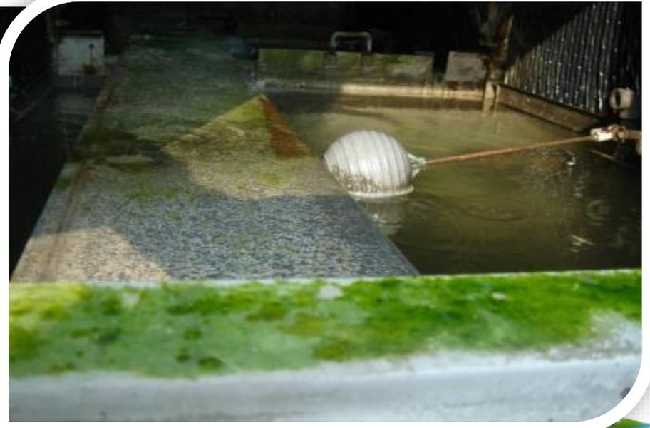
圖2.27 冷卻水塔未定期清洗或投藥及制菌之情形
