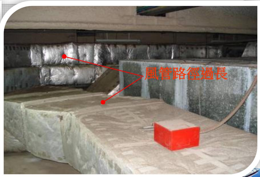
圖3.13 空調風管配置不當(90度急轉彎與扁平風管)
