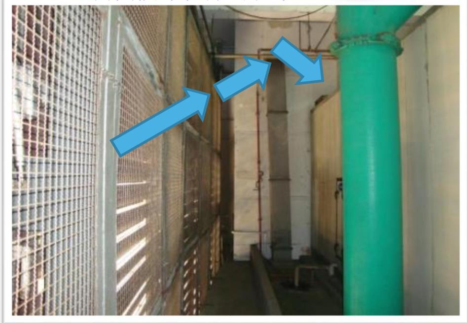
圖3.6 間接外氣引入方式往往無法確保外氣能真正進入空調箱
