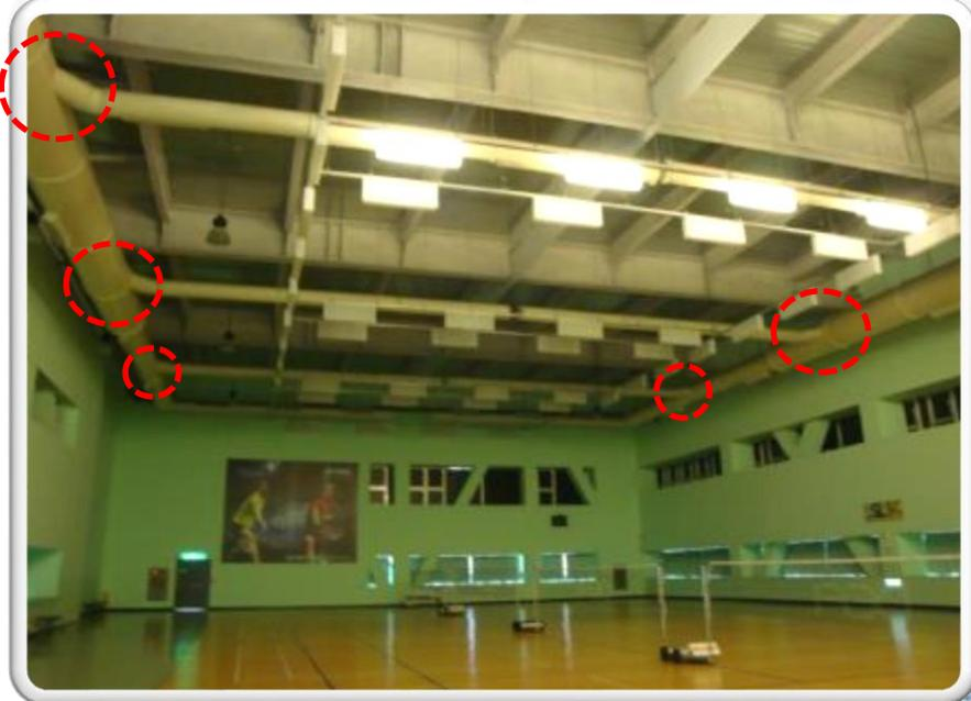
圖3.14 較佳（圓滑）的管線配置型態
