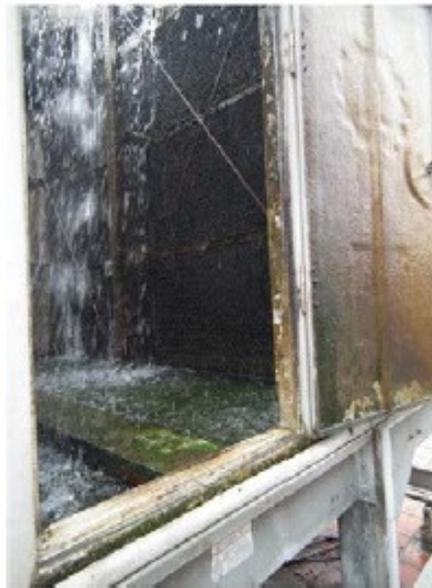
冷卻水塔分散水盤阻塞及冷卻水溢流
