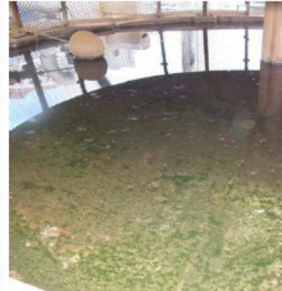
冷卻水塔之貯水池內藻類孳生情形
