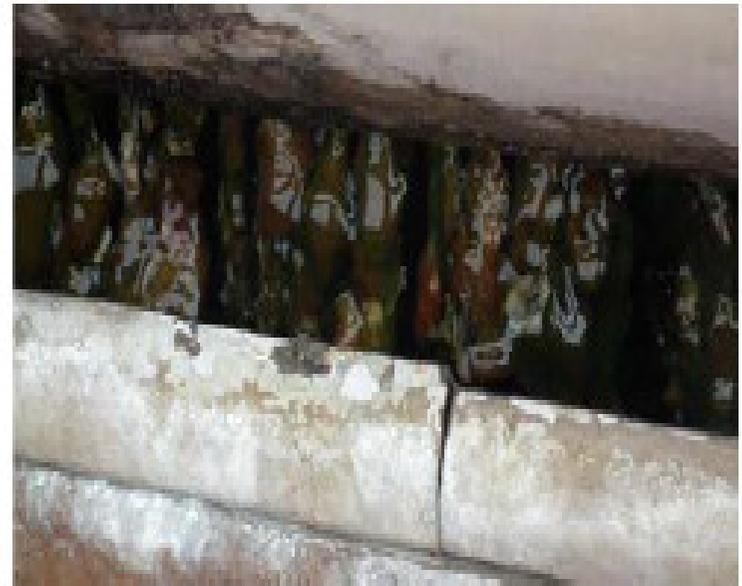
冷卻水塔附著髒污及漏水情形
