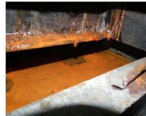
空調系統冷卻盤管髒污情形
