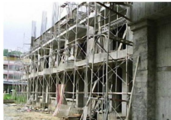
鋼筋混凝土結構 ( RC )
