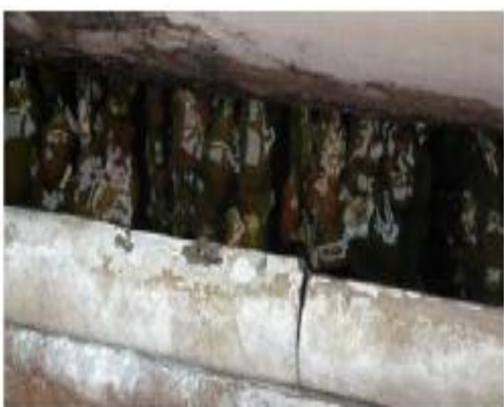
冷卻水塔附著髒污及漏水情形
