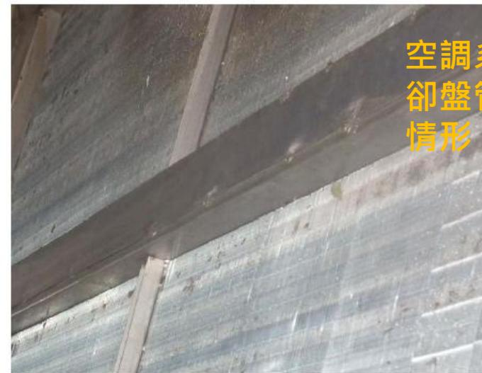
空調系統冷卻盤管髒污情形
